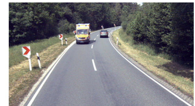
Abb. 21: Streckenfotos, links Vorher; rechts Nachher, der Zustandserfassung und-bewertung einer Kurve, an der flexible Richtungstafeln ausgestellt wurden [1]
